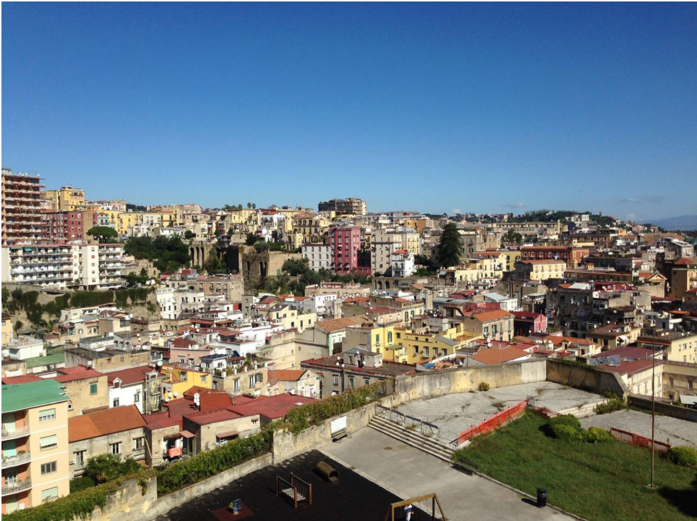
Il bastione dalla copertura dell'edificio C, foto di G. D'Ascoli.
