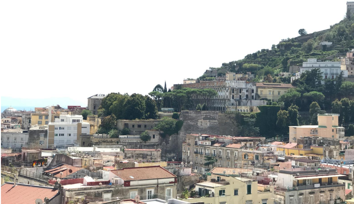
Il complesso visto dal Parco Ventaglieri, foto di G. Vannelli.
